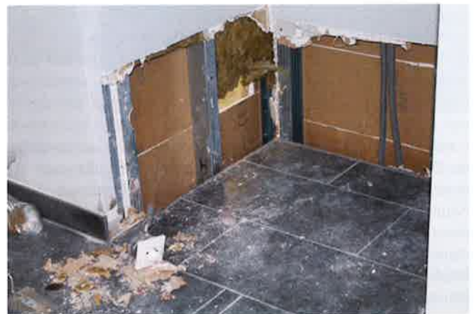
Abbildung 3: Beispiele Probenahme: Schüttung unter Estrich (unten), Gipskartonplatten (rechts oben), stehendes Wasser aus Elektroverrohrungen (rechts unten).
